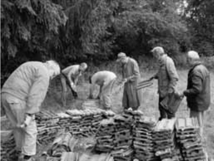
Abb. 8: Aus alten Dachpfannen entsteht eine neue Trockenmauer
