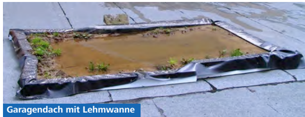
Garagendach mit Lehmwanne
