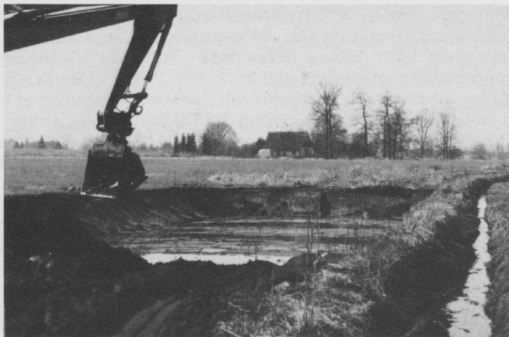
Abb. 2: Baumaßnahmen in den Rieselfeldern während der Optimierungsphase. Foto: W. Beisenherz
