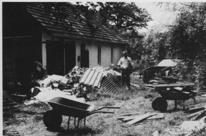
Abb. 26: Das Vereinsheim an der Wiesenstraße 21 während der Bauphase 1992. W. Grimm. Foto: H. Mensendiek
