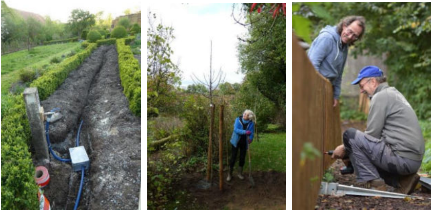
Neue Wasserleitung, neuer Apfelbaum, neuer Zaun im Bauerngarten Schelphof.
