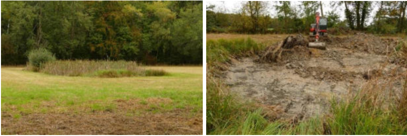
Abb. 32, 33: Teich 2 vor und während der Sanierung (Fotos: B. Walter).
